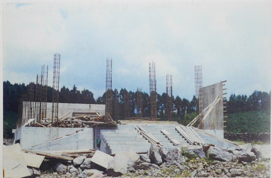
8.18. 1층 양구 공사중.
