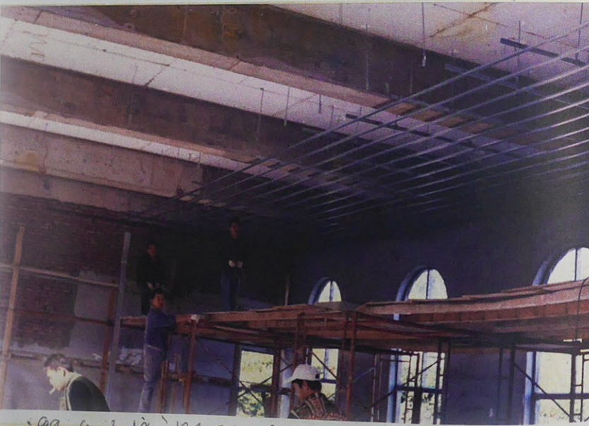
99. 12. 3. 1층 천장 철근 - 2층 마
