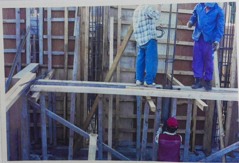
99.7.5 지리산 방파제공사 (현관부) 지리산 해안 (현관부)
