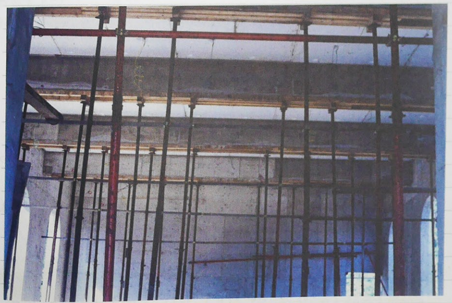
10.6 1층 용두 작업 공사
