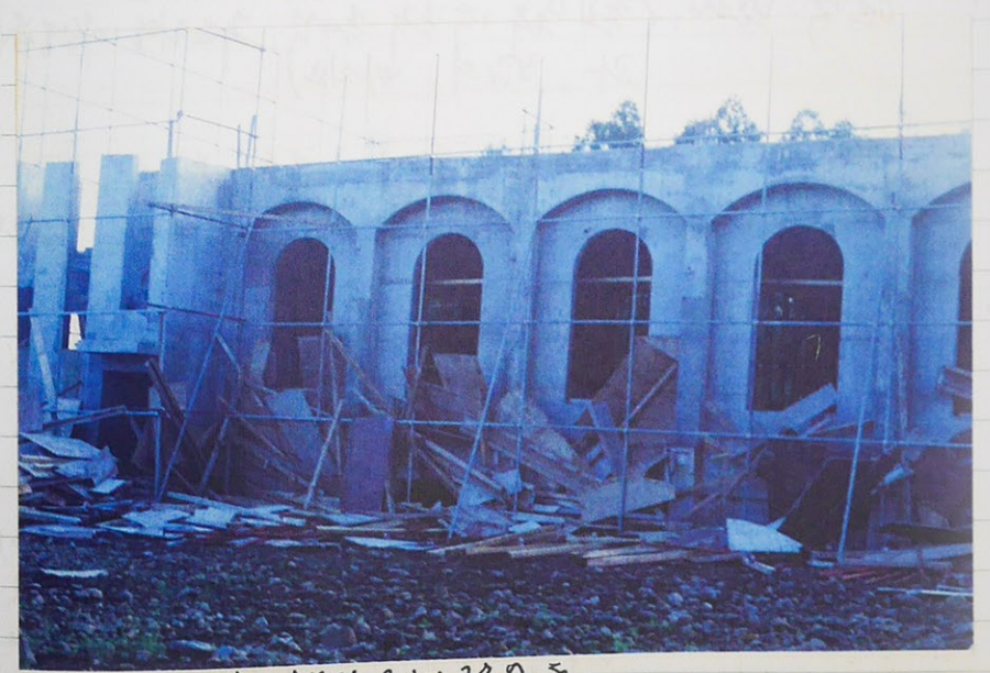
9.20 1층 거푸집 리기 작업 후
