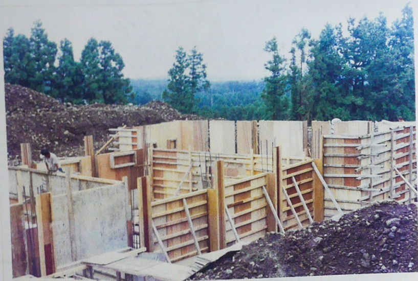
99. 7. 2 (토) 지반 조사 및 기초 공사
